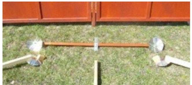
**(zu Pkt 7)** An den vorderen mittigen Pfosten wird ein Stützknief mittels zusätzlichem Scharnier angesteckt. Von hier laufen zwei Thekenstreben nach außen zu den Seitenteilen rechts / links und tragen die vier Tischbretter der Sektionaltheke.
