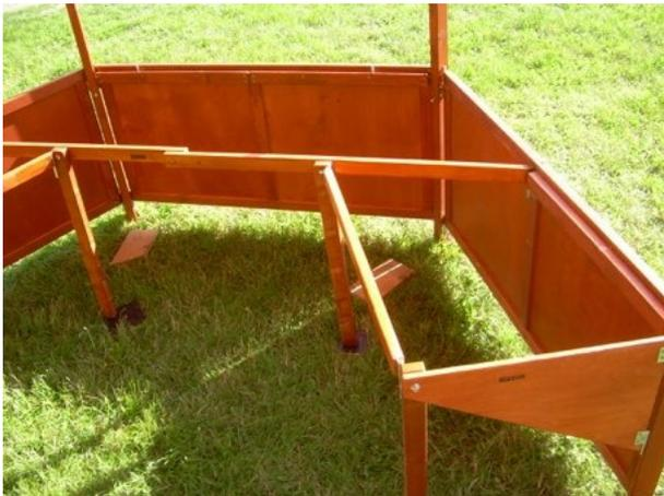
**(zu Pkt 7)** An den seitlichen Pfosten wird rechts und links ein Stützkniefestgestellt. Von hier laufen kurze Thekenstreben zur Thekenstütze vorne. Sie tragen die zusätzlichen Tischbretter der Seitentheke bzw. der großen Theke.
